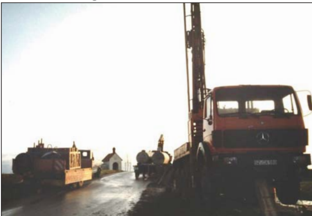
9. November 1992: Schwere Bohrmaschinen wurden aufgeföhren, um die geologische Beschaffenheit für eine Schlackendeponie zu erkunden.
